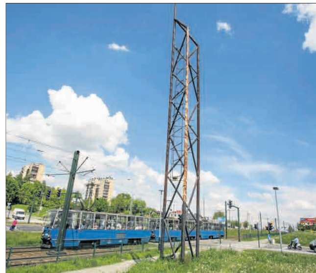
Przez lata konstrukcja nie budziła zaniepokojenia urzędników
